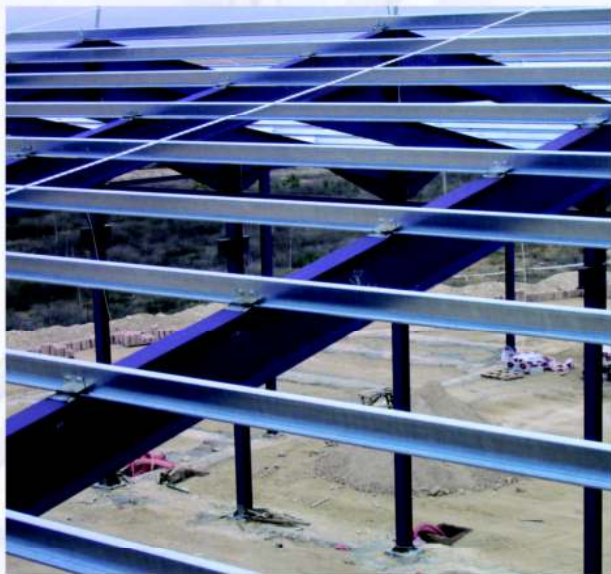
Ejemplo de aplicación del perfil Z-PA en una edificación industrial.
